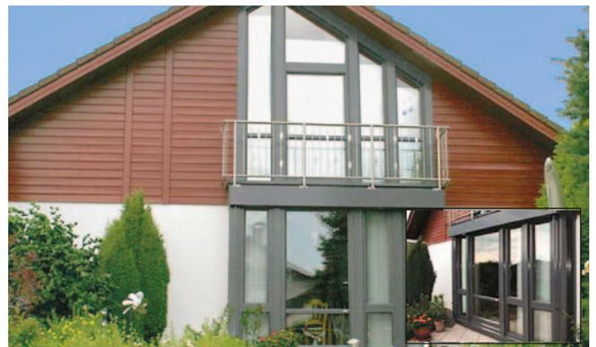
Außen widerstandsfähiges Aluminium, innen wohnliches Holz: Das jahrzehntlang bewährte Portas-Renovierungssystem bietet eine dauerhafte Lösung gegen Witterungsschäden und garantiert den Fenstern so eine lange Lebenszeit.
