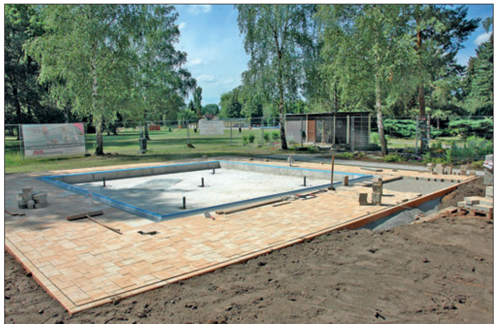
Aktueller Fortschritt – Sanierung Planschbecken Freibad Regis-Breitungen
